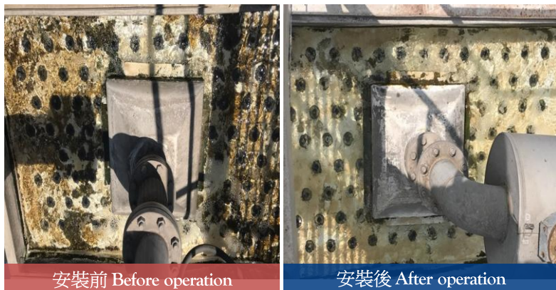
冷卻塔除水器狀態對比 安裝後35天
