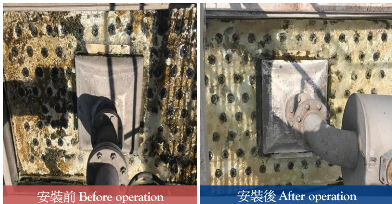
冷卻塔除水器狀態對比 安裝後35天
